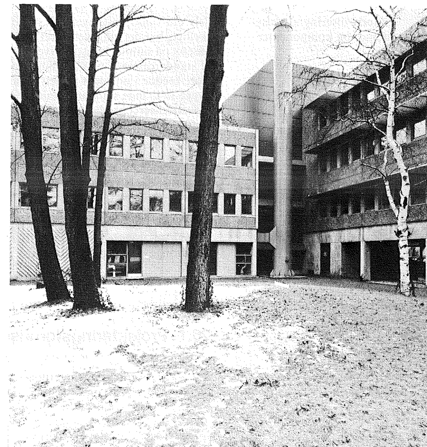
Kontorhus i Lyngby opført af Rasmussen & Schiøtz A/S i totalentreprise. Projektet er baseret på firmaets kontortypehus.
