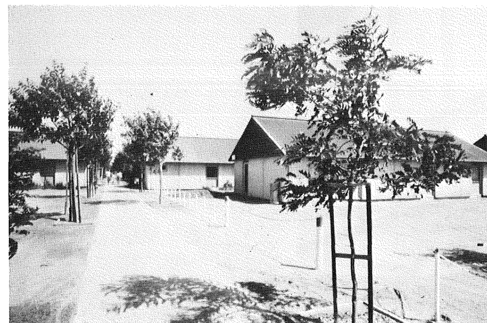
Figur 15.17 350 enfamiliehuse opført af Højgaard & Schultz ved Jeddah i Saudi Arabien. Arkitekt: Klaus Johansen.
