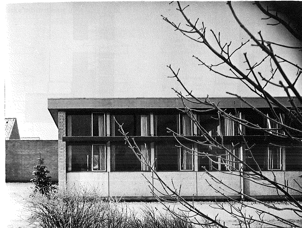
Figur 18.04 Skole med betonfacadeelementer og skalmurede gavle.
