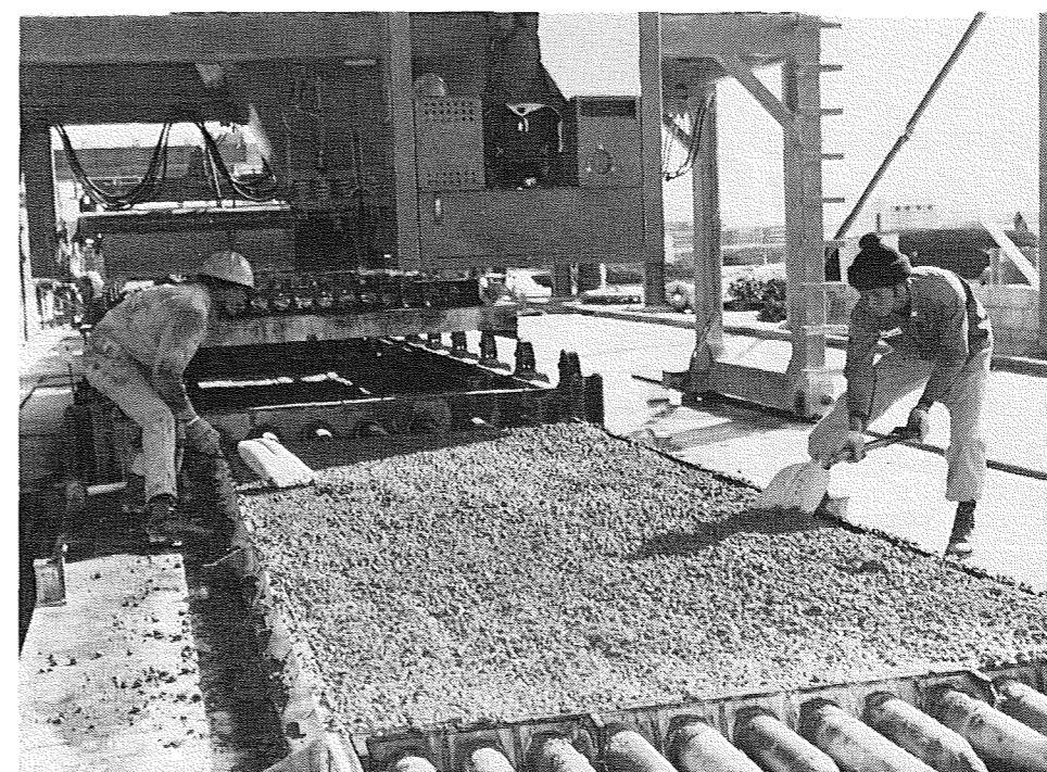
Figur 13.05 Dækstøbning med dornmaskine på en LN-fabrik i Saudi Arabien.
